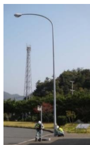
街灯支柱の健全性評価
